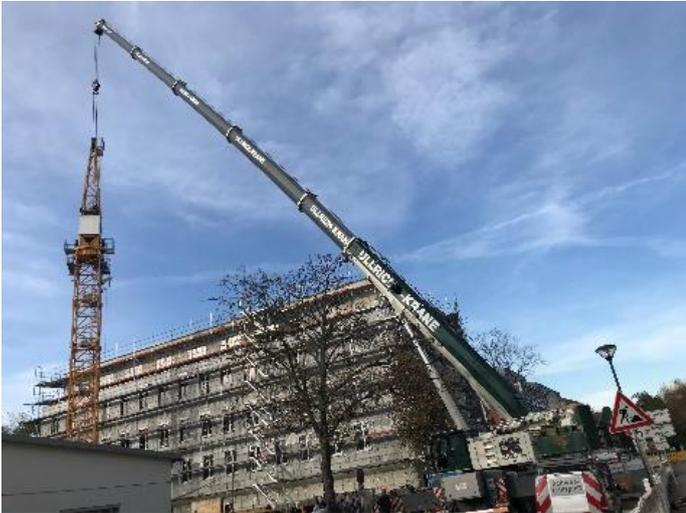
Ebenso konnte am 22. und 23. Oktober der Kran zurückgebaut werden, was weithin gut zu beobachten war. Aktuell werden Dachbahnen aus flexiblem Polyolefinen verlegt, womit das Flachdach des Maria-Merkert-Hauses zeitnah abgedichtet sein wird.
